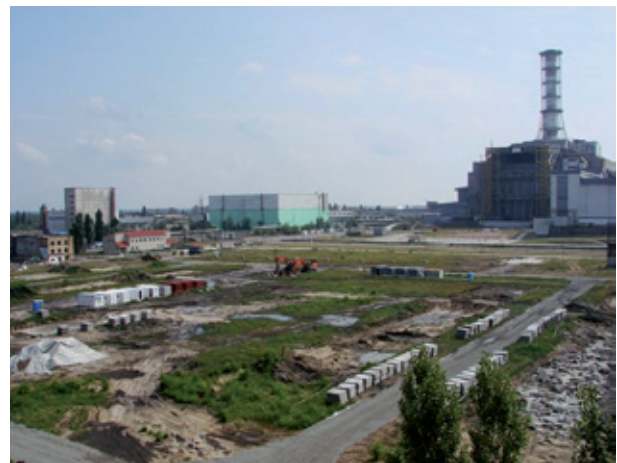
2011 - Vorbereitung der Errichtungsfläche des New Safe Confinement (NSC) vor stabilisiertem Sarkophag - Quelle EBWE.
