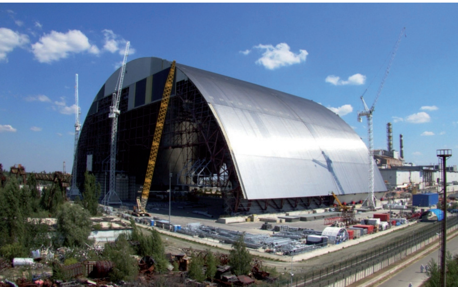
August 2015 - Blick auf die zusammengeschlossenen Hälften des NSC - Quelle ChNPP.
