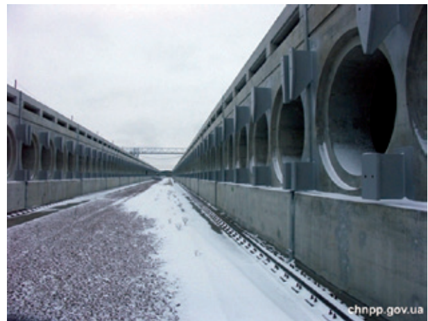
ISF-2 Beton-Lagerblöcke zur Aufnahme der DWC – Quelle ChNPP.
