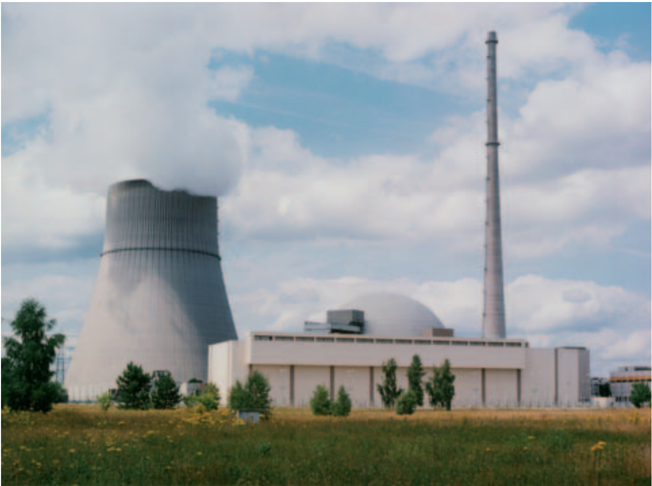
Zwischenlager am Standort Lingen in unmittelbarer Nähe zum Kraftwerk
