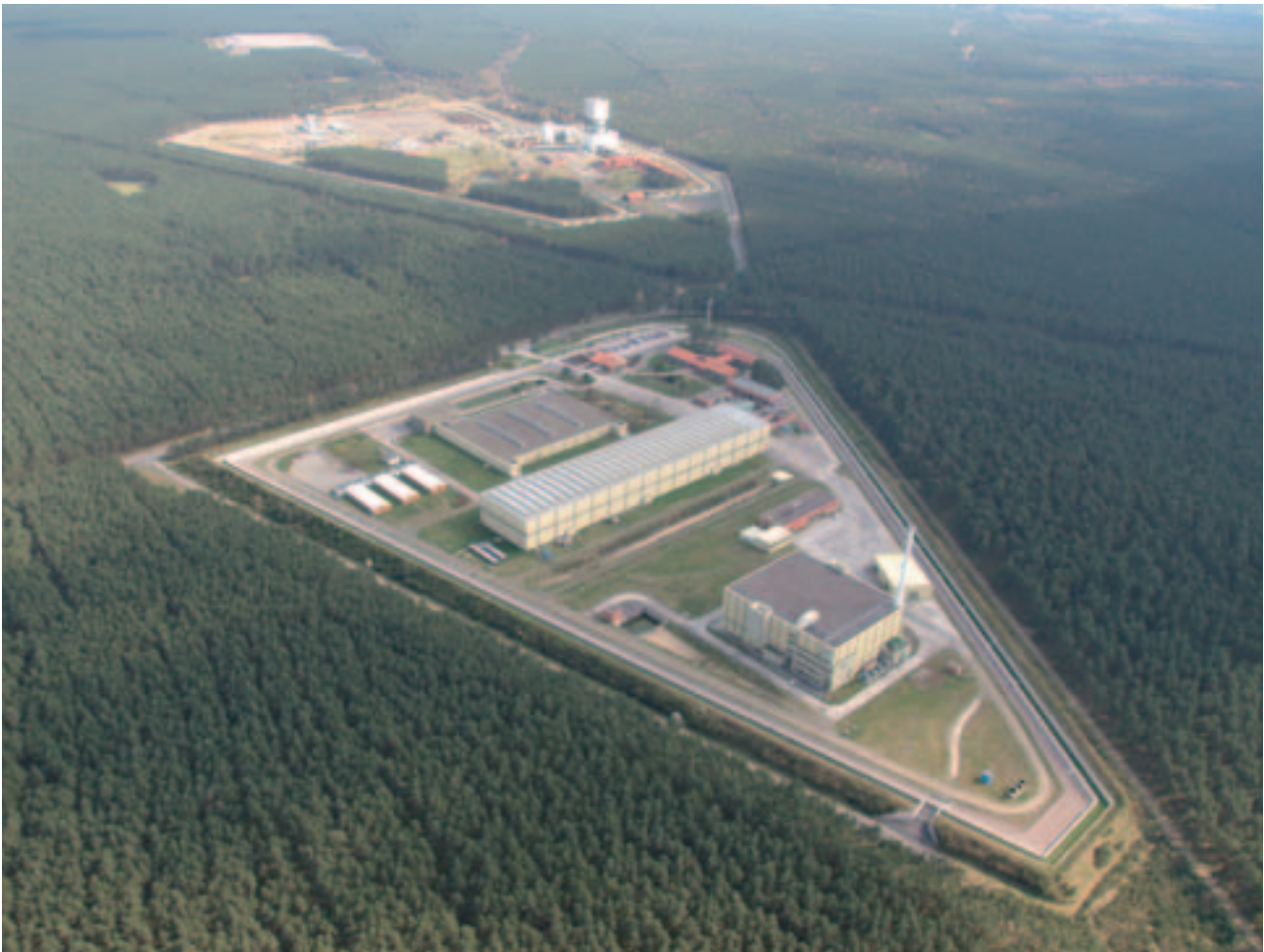
Anlagen in Gorleben (Luftbild): vorn das Transportbehälterlager und die Pilotkonditionierungsanlage, hinten die oberirdischen Anlagen des Erkundungsbergwerks.
